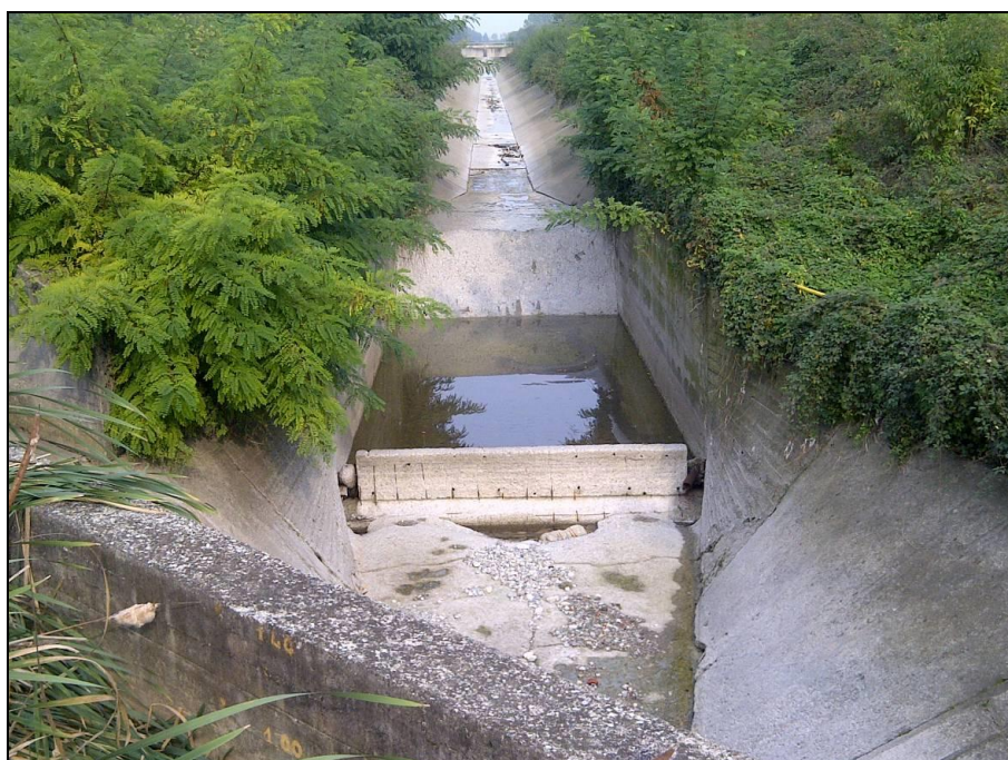
Figura 13 – Vasca di dissipazione esistente a valle del salto ove a monte è prevista la realizzazione dell'opera di presa dal CSNO
